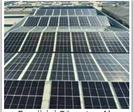
Enerjisini Güneşten Alan Çevreye Duyarlı Üretim
